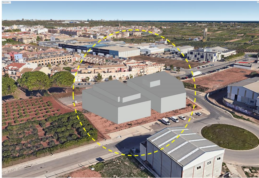
Vista de la actuación hacia el Oeste.
