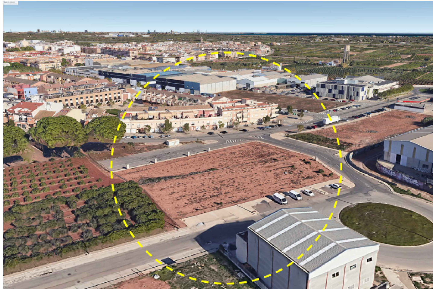
ESTADO ACTUAL VISTA OESTE
